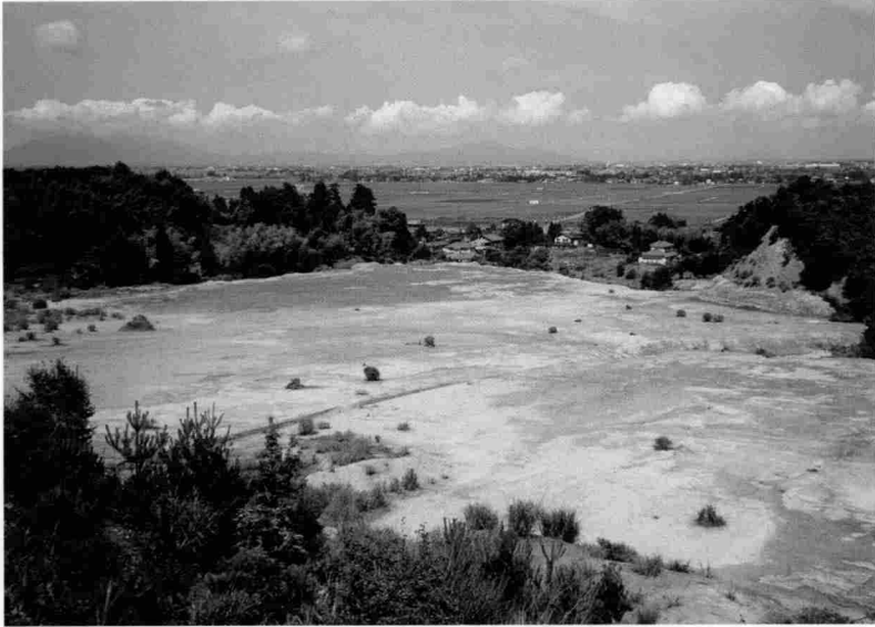
松ヶ丘団地造成地の全景
